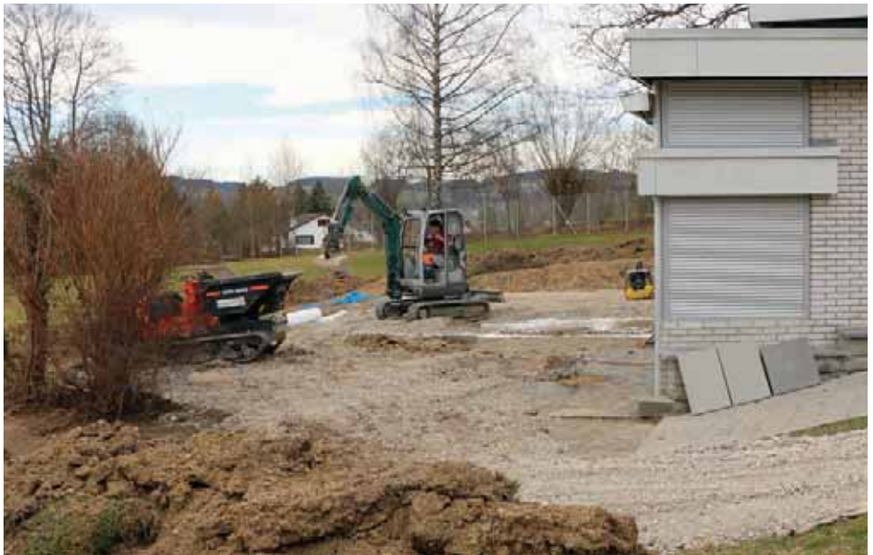
Umbau Badi-Terrasse, Stand 23. Februar 2017
