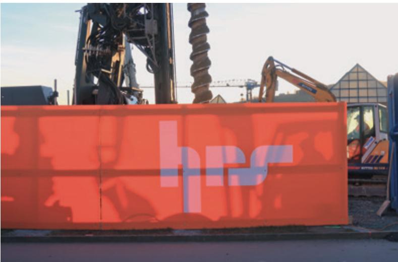
Hinter dem Bauzaun gehen die Arbeiten zügig voran. Bohrungen für die Rühlwand zur Baugrubensicherung.
