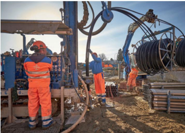
In die Bohrlöcher wurden dicke Rohre eingeführt, in diese werden jetzt die je zwei Doppel U-Sonden eingeführt.
