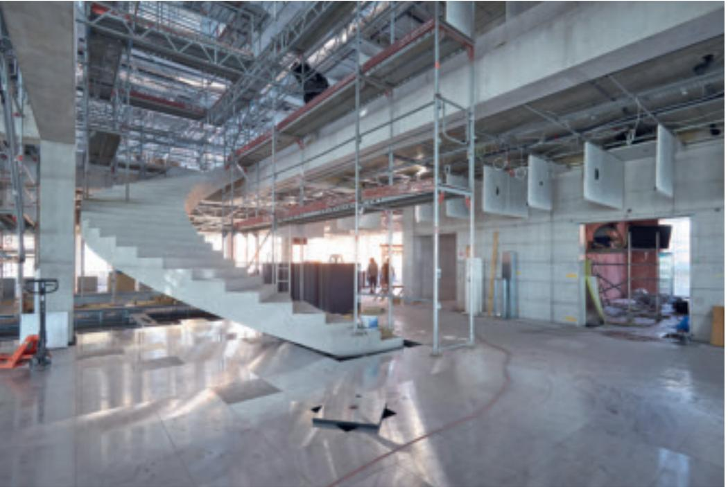
Noch versperrt das Gerüst im Innern die Sicht ins Atrium. Die elegant geschwungene Treppe mit dem Boden gibt bereits einen Eindruck vom fertigen Bau. Die Technik verschwindet langsam unter dem Boden oder in der Decke. Noch hängen die Deckenelemente mit den Stickerei-Mustern nach unten.
