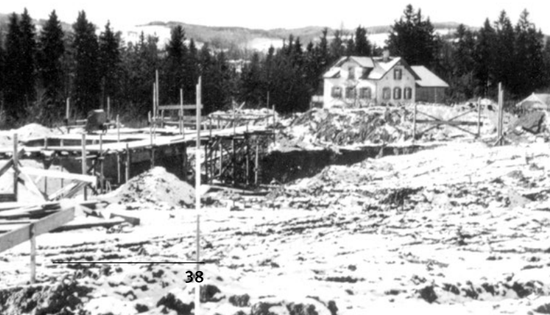
Die Baustelle Blickrichtung Klosterweidli- strasse. (Januar 1951)
